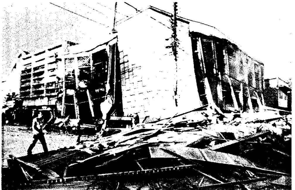
Erdbeben-Schäden auf Mindanao: Den Sturm überm eigenen Dach...
